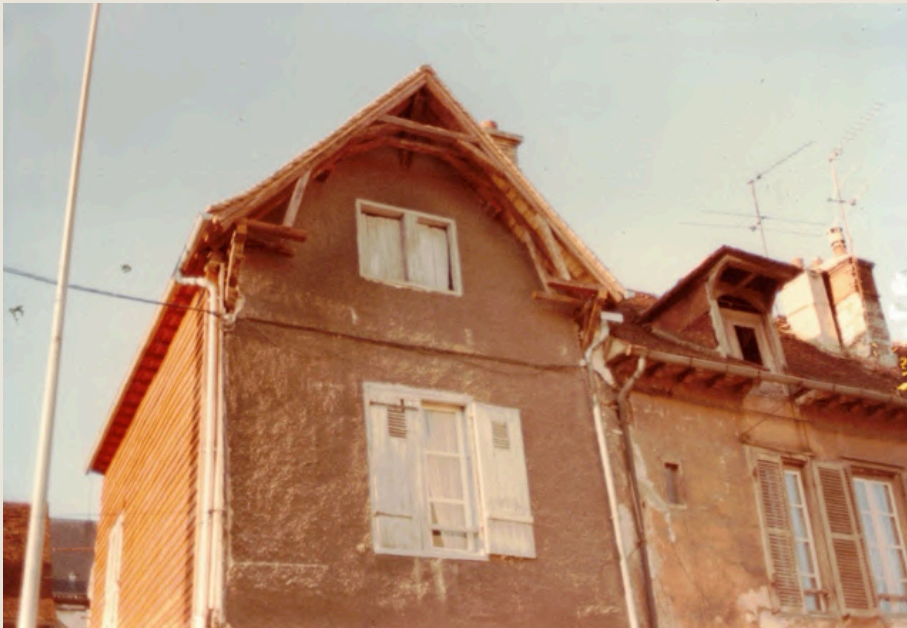
En cour de restauration (1982)
