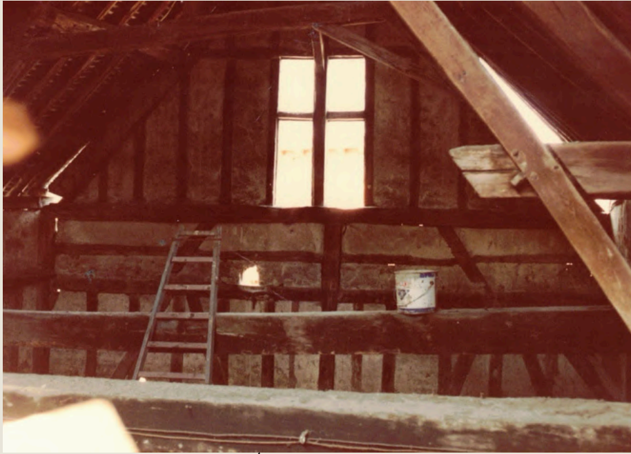
Avant travaux Before work
