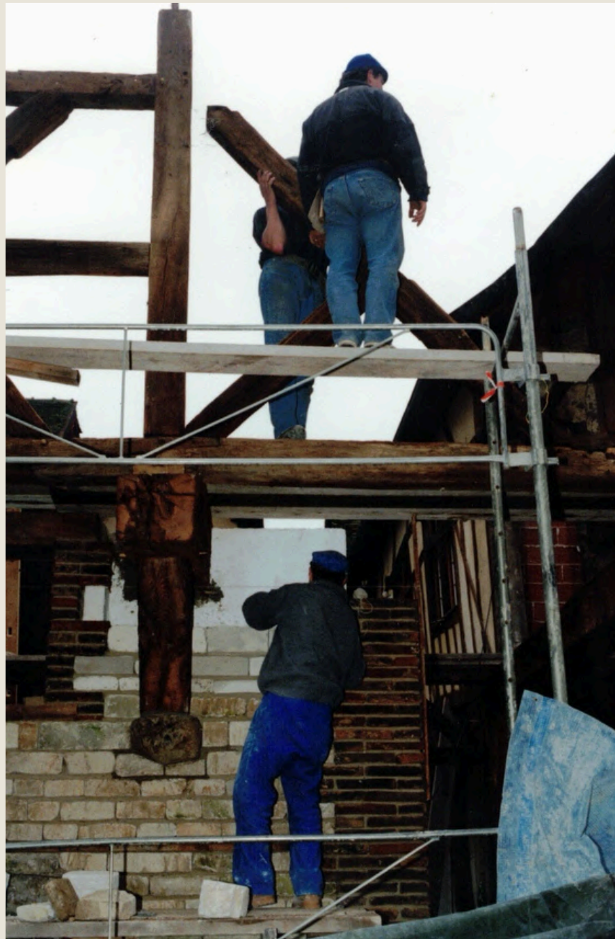
Co-activité entre le maçon au rez-de-chaussée et les charpentiers sur l'échafaudage.
