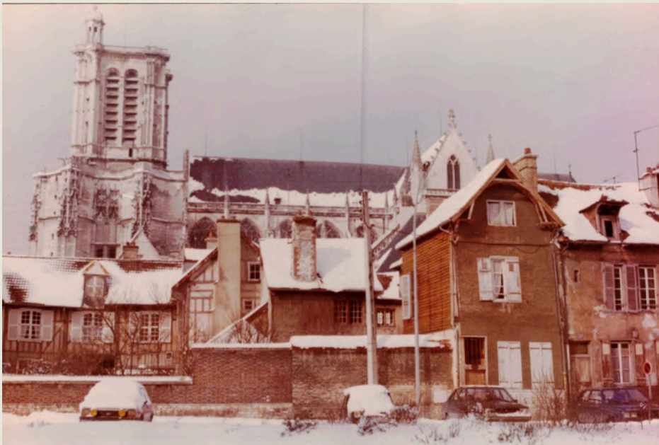
Avant restauration, rue St-Denis sous la neige (1985) La Maison de Rhodes à gauche, le Champ des Oiseaux à droite.
