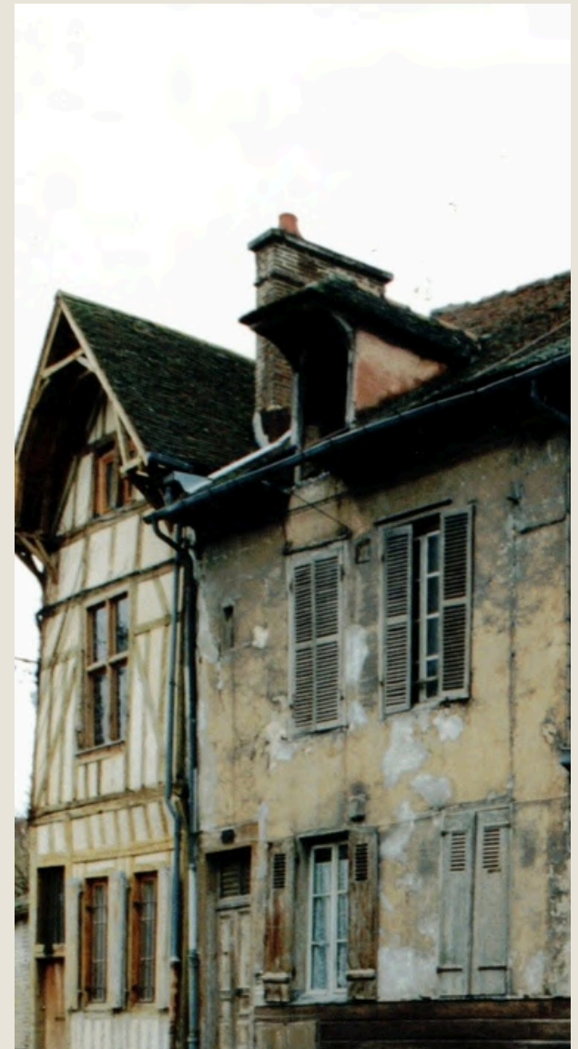
Façade rue St-Denis qui vient d'être restaurée (1989). La maison voisine au n°19 est encore dans son jus.
