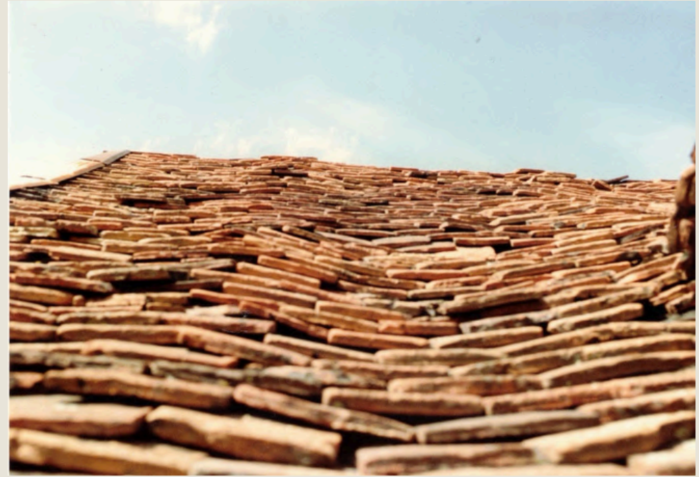
État initial de la toiture
