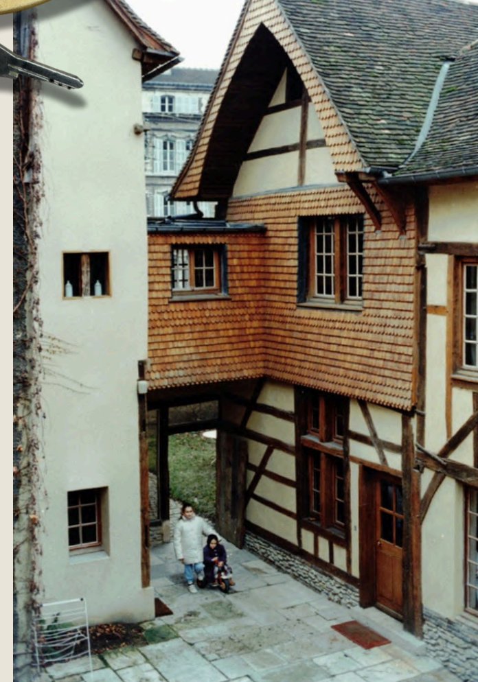
Les travaux sont achevés : deux de mes filles Marie et Julie. La plus jeunes deviendra 40 ans plus tard propriétaire des deux hôtels avec son mari, Kamil.
