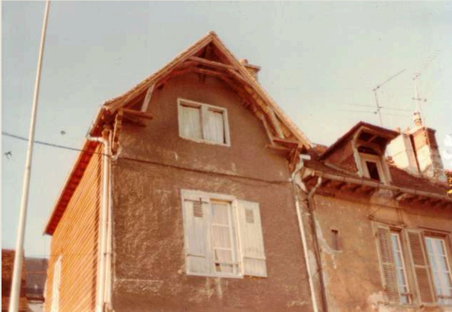
En cour de restauration (1982)
