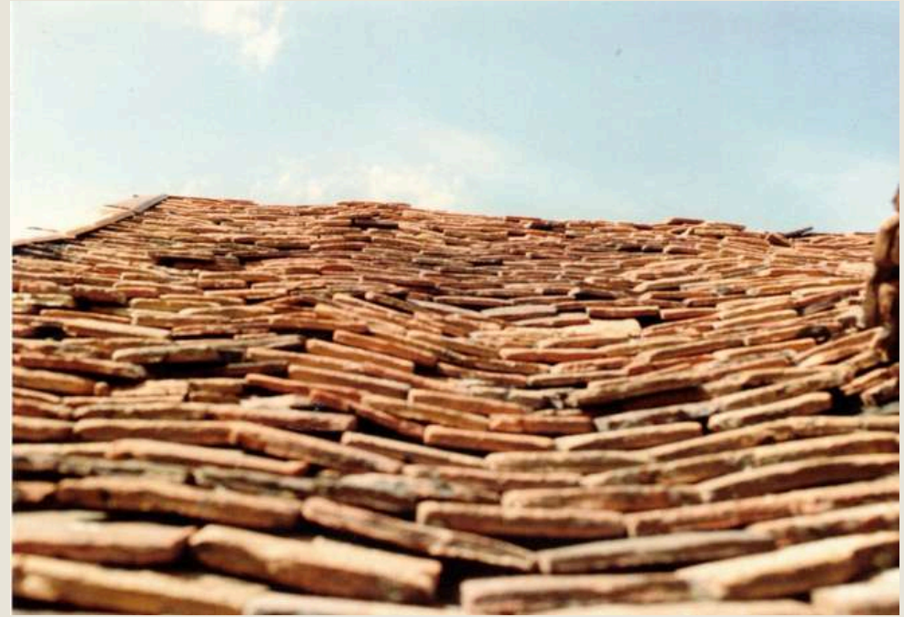
État initial de la toiture
