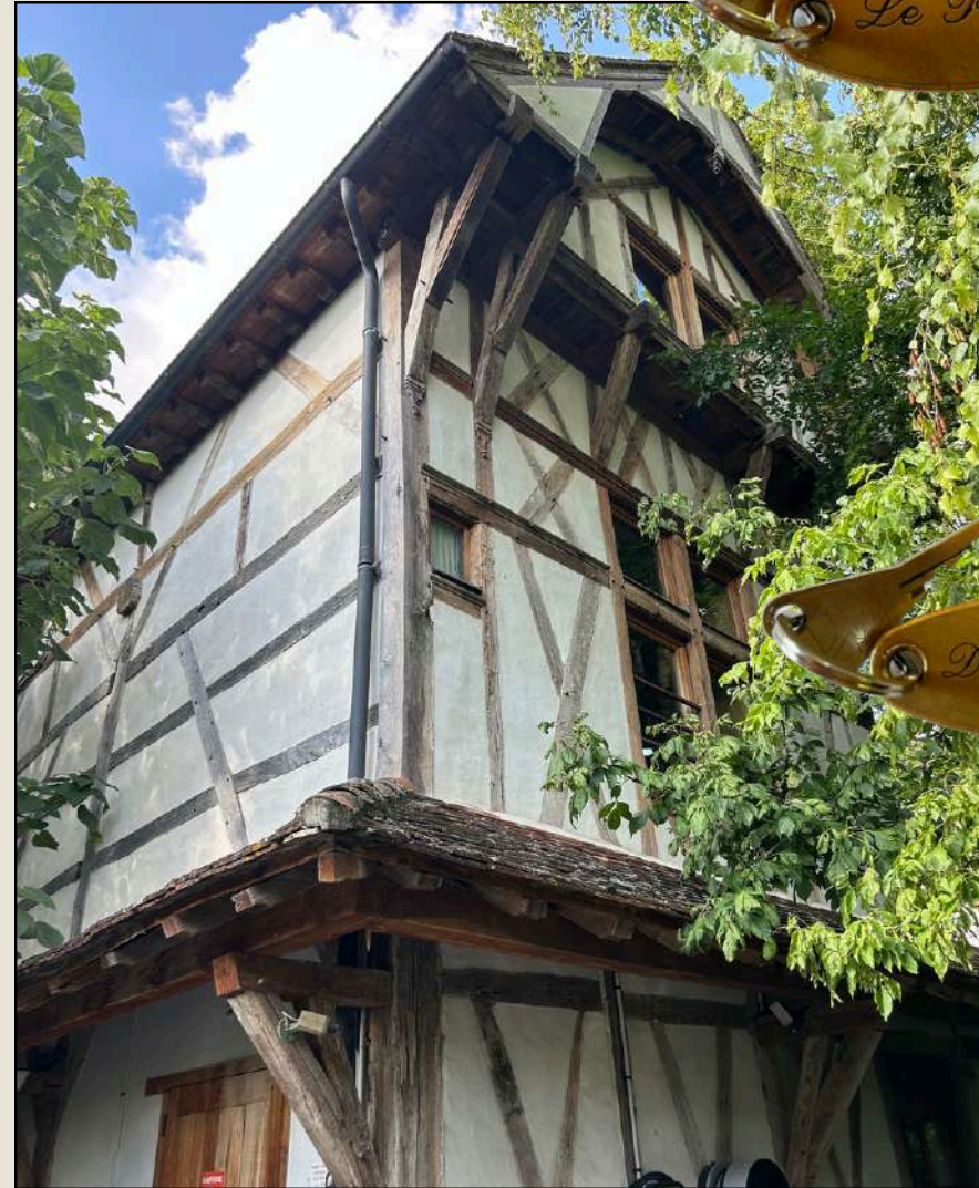
Façade sud-ouest coté rue Saint-Denis avant et après travaux. Cette ferme d'avant-corps repose sur un encorbellement au niveau du plancher du comble.
