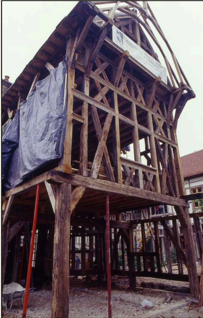
Façade sud-ouest coté rue Saint-Denis avant et après travaux. Cette ferme d'avant-corps repose sur un encorbellement au niveau du plancher du comble.
