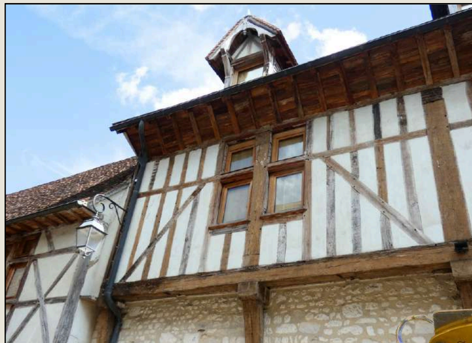
Après travaux/ After the renovations
