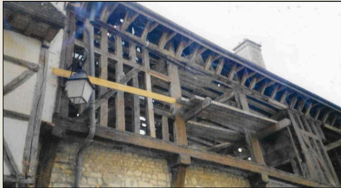
Pendant les travaux Octobre 2001 façade Nord, Rue Linard Gonthier During the renovations, October 2001, North facade, rue Linard Gonthier
